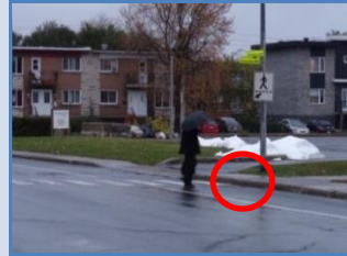
Absence de bateau-pavé à une extrémité du passage piétonnier sur la rue Darveau (près de la piscine)
