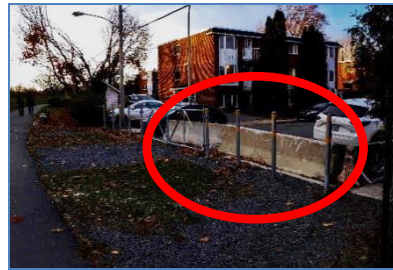
blocs de béton et poteaux aux entrées de la piste cyclable
