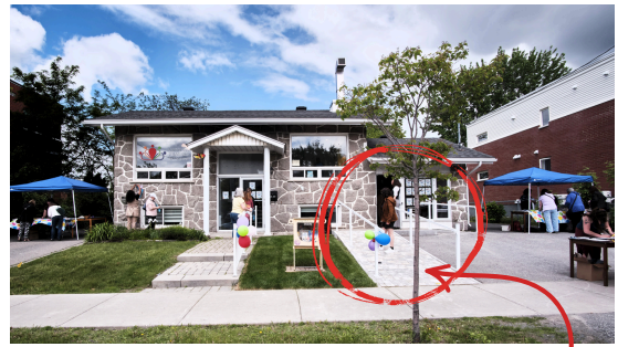
Le Centre est maintenant doté d'une rampe d'accès à l'extérieur.
